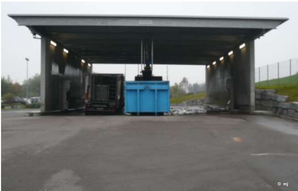
Waschanlage beim Schlachthof.
